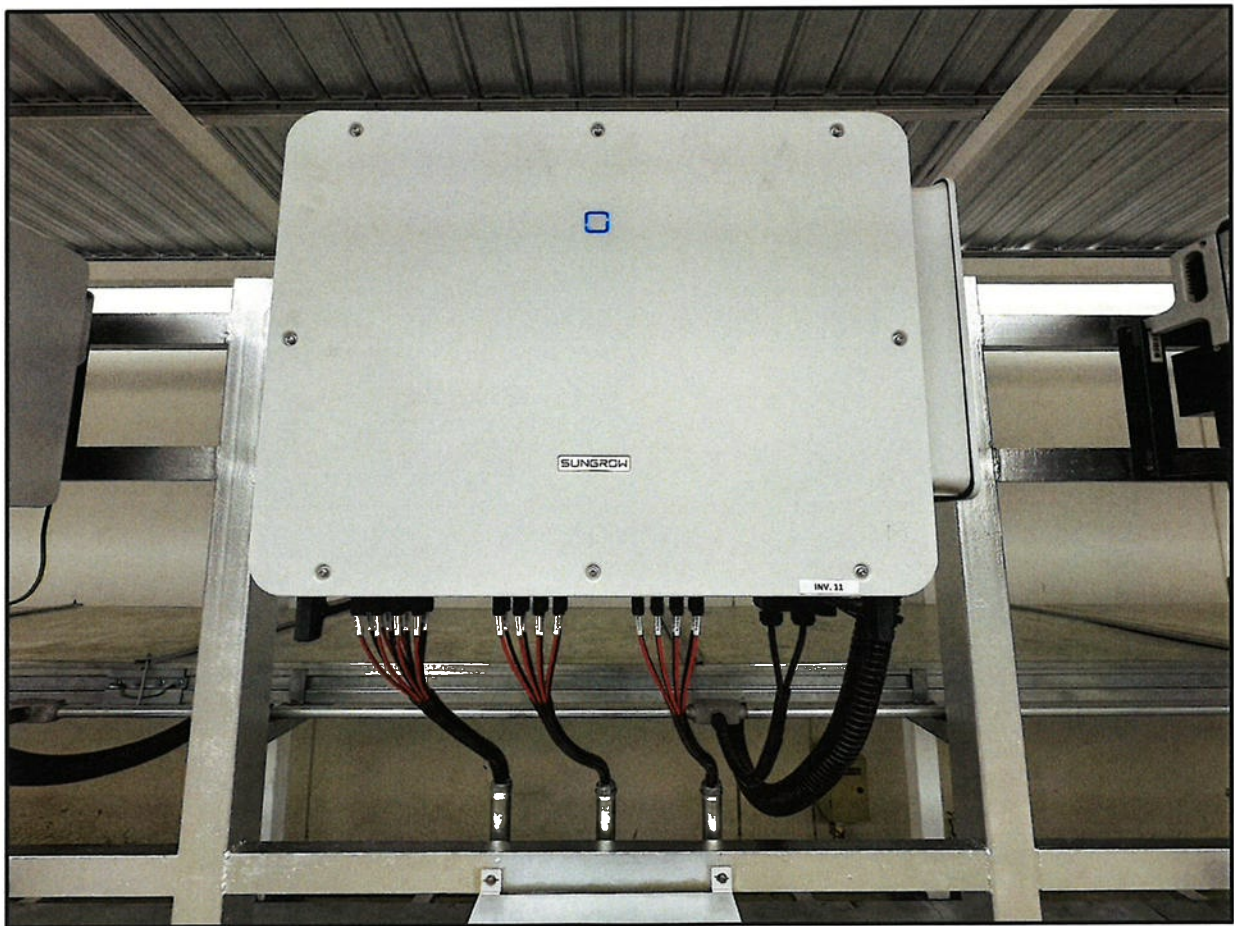
รูปที่ 2.4.3-4 ภาพตัวอย่างการติดตั้งโครงอลูมิเนียมและอินเวอร์เตอร์
